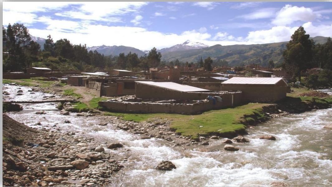
*Foto 01: Año 2007; Sector este de la ciudad de Huaraz, limitada por la confluencia de los ríos Llaca y Cojup, donde se observan viviendas de adobe de un piso de construcción a pocos metros del cauce del río, en la imagen la acumulación de depósitos de flujo, son más notorias hacia la margen izquierda del río Llaca, teniendo menos depósitos del flujo en los bordes del barrio de Nueva Florida.*
