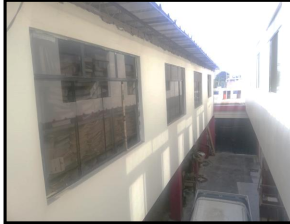
Se observa el interior de los ambientes de la UGEL HUARMEY
