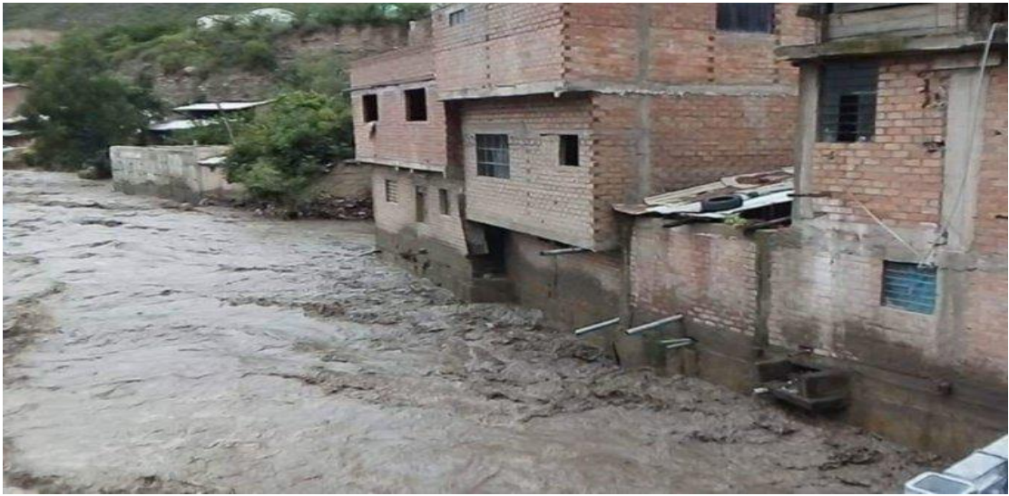
IMAGEN N°09 INUNDACIÓN por crecida de río, Distrito de RAHUAPAMPA, Provincia HUARI.
