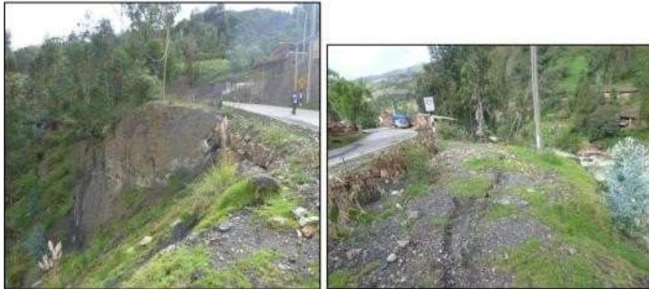
**Fotos 5 y 6:** Izquierda, escarpe de deslizamiento activo, derecha, grietas y saltos de deslizamiento.
