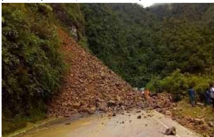
IMAGEN N°02: Deslizamiento de terreno sobre la carretera
